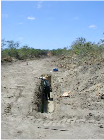
PHOTO 20: Trench D-2, view N.
